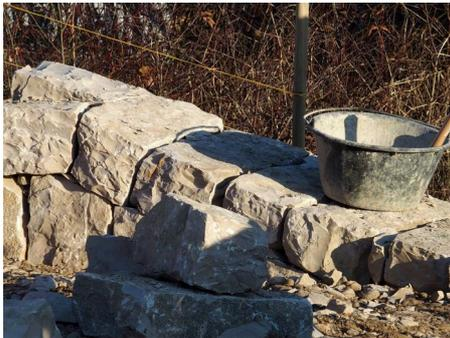
Trockenmauerbau ist eine Wissenschaft für sich. Kurz zusammengefasst braucht es aber vor allem Steine und Geduld. Pro Quadratmeter freistehender Mauer muss mit ca. einer Tonne Steine gerechnet werden.
